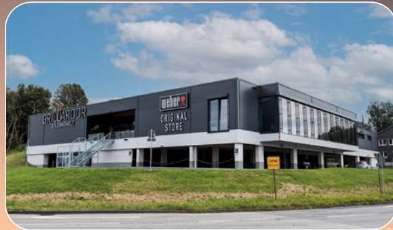
Hochbau Weber Original Store Grillardor
