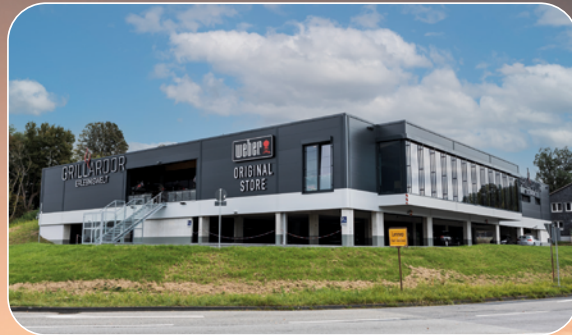
Hochbau Weber Original Store Grillardor
