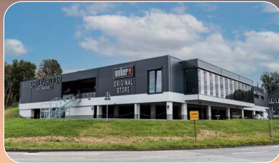
Hochbau Weber Original Store Grillardor
